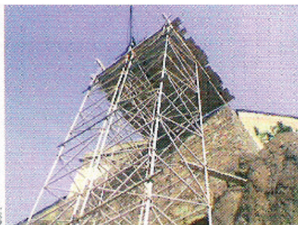
Travaux pour construire le Borj
